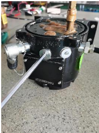
拆卸卸荷阀堵头
