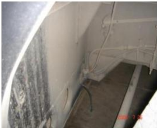
图 17 电子传感器插头脱落
